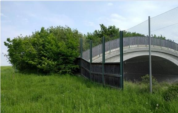
*Positives Beispiel : fachgerechter Anschluss des Zaunes auf Höhe des seitlichen Blendeschutzes; niedere Hecke dient als Leitstruktur auf dem Bauwerk*
