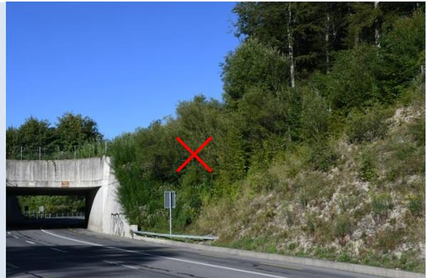
Die Entwicklung von Büschen an den Böschungen zwischen Zaun und Fahrbahn leitet die Fledermäuse neben der Überführung durch und erhöht somit das Kollisionsrisiko stark
