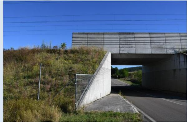
*Anschluss des Zauns im unteren Teil des Eingangs einer grossen Unterführung*
