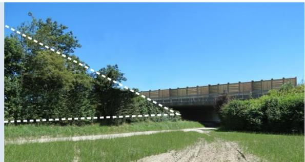
*Das Reduzieren der Heckenhöhe mit einem differenzierten Unterhalt, verbunden mit dem Aufstellen von Schutzwänden gegen Licht, bewegt strukturgebundene Fledermäuse dazu, ihre Flughöhe zu reduzieren und in die Unterführung zu gelangen*
