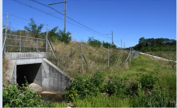
Die Zäune werden oberhalb des Bauwerks durchgeführt und leiten Fledermäuse in die Unterführung
