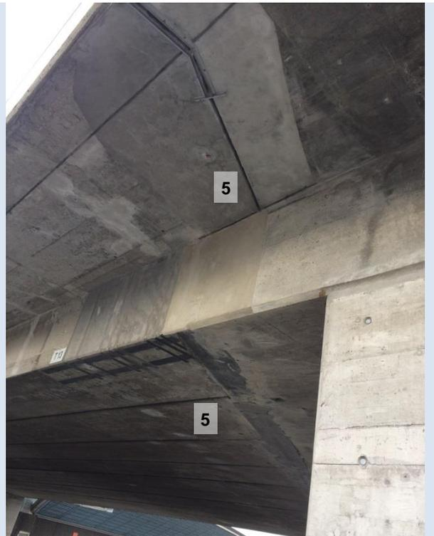
Mögliche Zugänge zu (Spalt)Quartieren für Fledermäuse an Brücken: Mannloch (2), bei dem die Fledermäuse seitlich vom Gitter durchkriechen; Entwässerungs- oder Lüftungslöcher (3), Spalten beim Widerlager (4), Dilations- oder Elementfugen (5).
