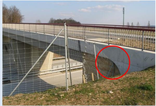
Negatives Beispiel : falscher Anschluss unter das Brückenbauwerk bewegt die Fledermäuse dazu, die Strasse zu überfliegen
