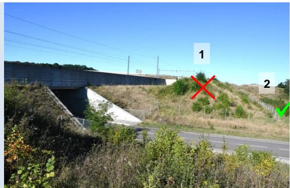
Die sich entwickelnden Sträucher im oberen Teil der Böschung könnten Fledermäuse dazu bewegen die Bahngeleise zu überfliegen (1); die Sträucher am Fusse der Böschung, ausserhalb des Zauns (2), leiten die Fledermäuse zum Eingang der Unterführung
