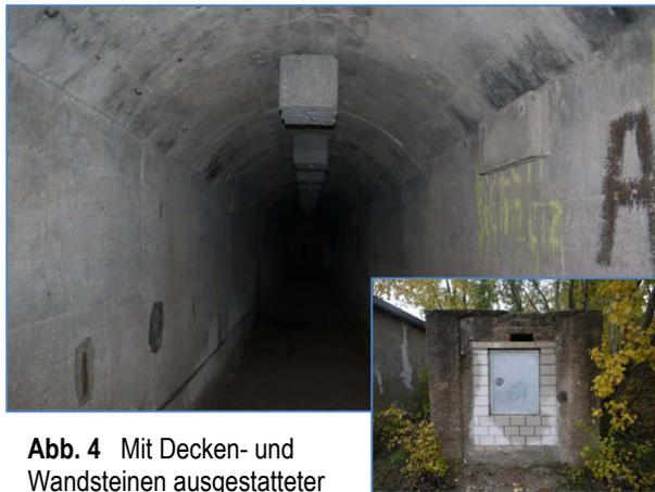
**Abb. 4** Mit Decken- und Wandsteinen ausgestatteter Bunker, kleines Bild Zugang mit Einflugöffnung.
