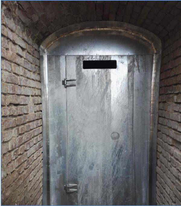
**Abb. 2 bis 4** Neue Zugangstür mit hochgelegenen Einflug und einem Blendrahmen, der das Erklettern der Einflugöffnung erschwert und oben rechts alte Zugangsluke mit Einflug direkt oberhalb, der vom Sims leicht zu erreichen war.
