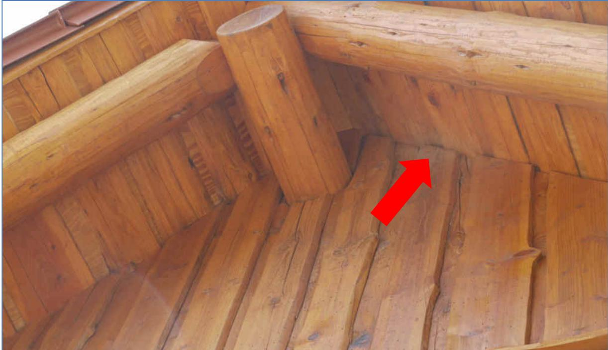
**Abb. 1** Giebelwand mit Fledermauskotkrümeln und markiertem, leicht verfärbtem Haupteinflug.
