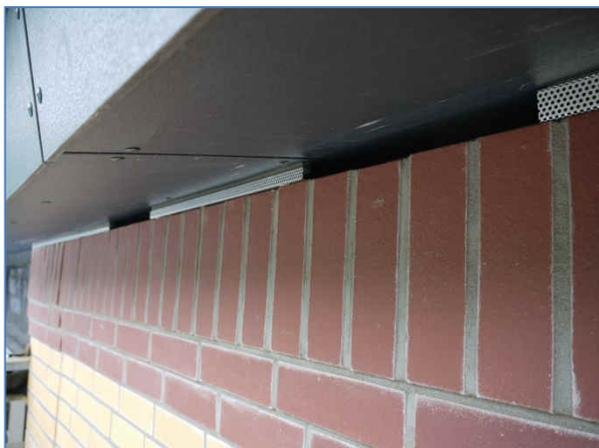
**Foto 1 und 2** Zwischen den Dachbindern des Erweiterungsneubaus der Sportschule Zinnowitz wurden Quartierkästen integriert, die über einen Spalt direkt unter dem Traufkasten zu erreichen sind.
