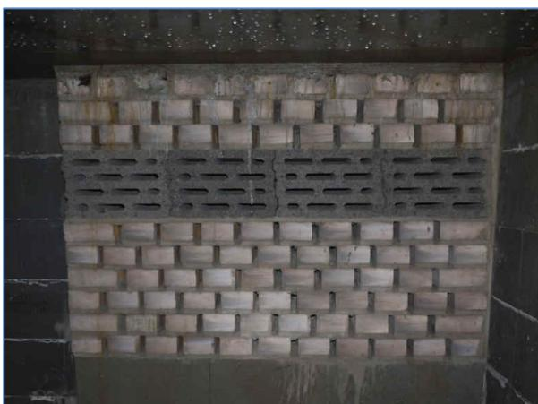
**Abb. 3** Spaltenwand mit gut einsehbar eingebauten Hohlkammersteinen im Quartier Küchengarten.
