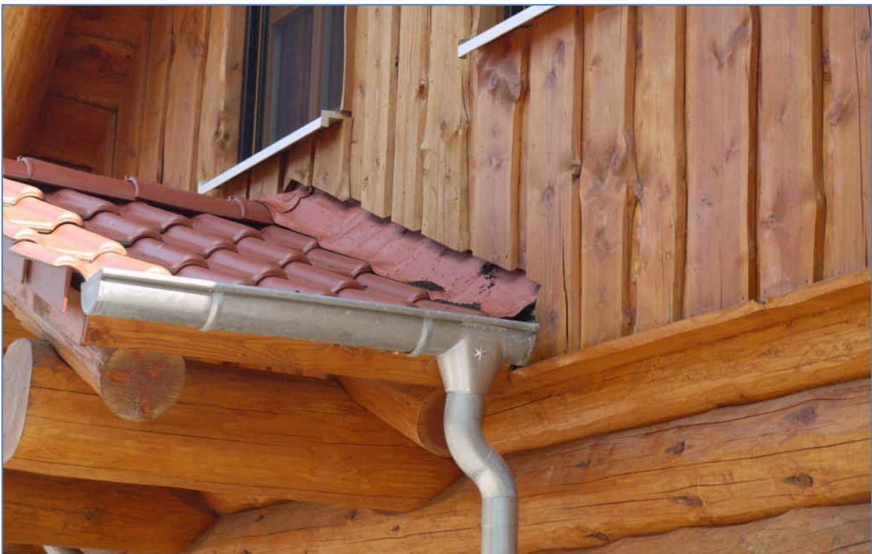
**Abb. 2** Aus der Giebelwandverkleidung auf eine Vordach rieselnder Fledermauskot.
