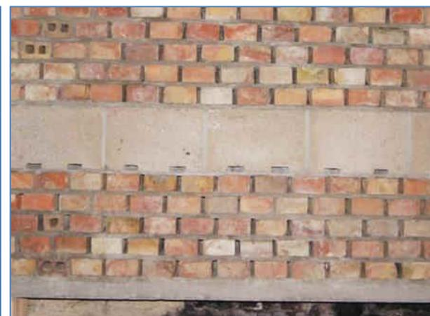
**Abb. 4** Spaltenwand mit angeschnittenen nur endoskopisch einsehbare Hohlkammersteine.
