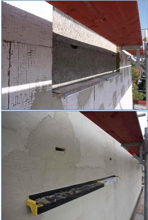
Abb. 3 und 4 rechts Im WDVS integriertes Fassadenquartier aus HWL-Platten.
