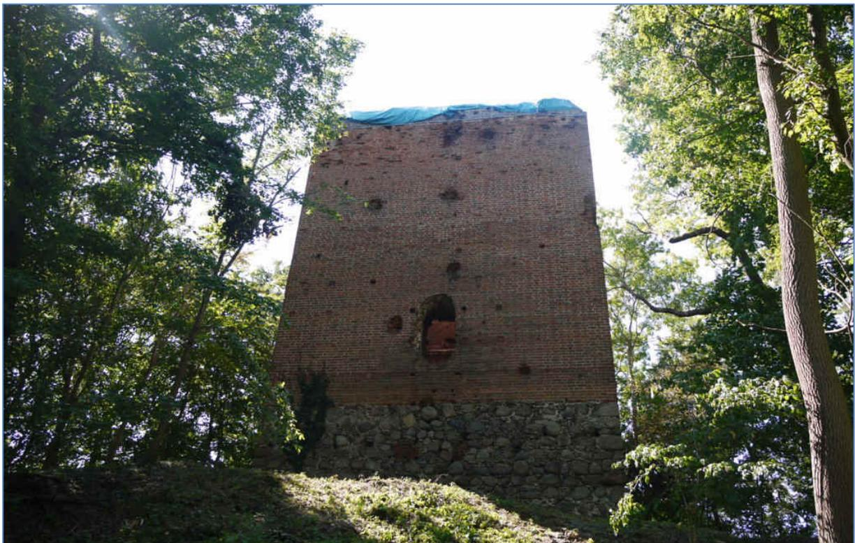
Foto 4 Fangelturm Nehringen mit gesicherter Mauerkrone.
