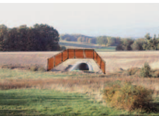
Foto 50: Fließgewässerunterführung in Kombination mit einer notwendigen, darüber dauerhaft installierten Sperranlage, die gleichzeitig einen Blendschutz bietet, um ein ungestörtes Unterqueren der Trasse für strukturgebundene Fledermausarten zu begünstigen (vgl. auch Foto 49). Entsprechende Leitpflanzungen zum Bauwerk sind noch zu ergänzen.
