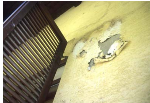
Abb. 4-42: Schäden an der Außenfassade durch den Urin und Kot einer Wochenstube der Mopsfledermaus hinter Fensterläden (Bad St. Leonhard, Kärnten, A). Fotos: M. Jerabek
