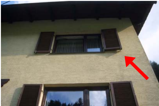
Abb. 4-42: Schäden an der Außenfassade durch den Urin und Kot einer Wochenstube der Mopsfledermaus hinter Fensterläden (Bad St. Leonhard, Kärnten, A). Fotos: M. Jerabek
