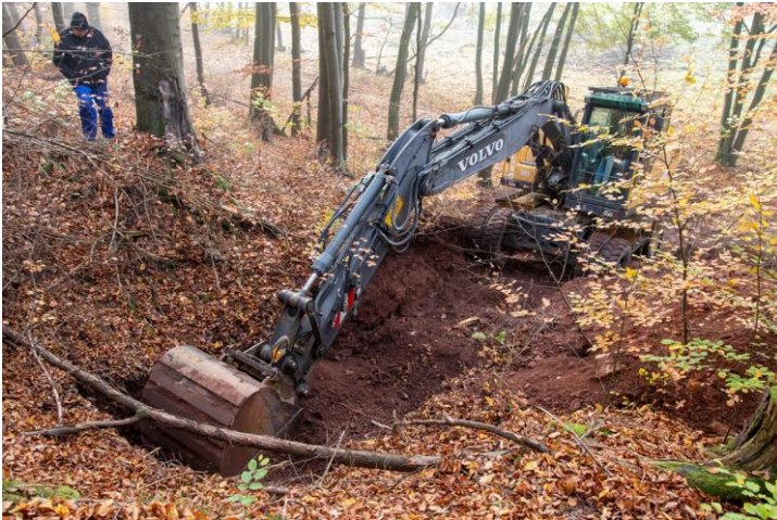
Öffnung und Sicherung des Ölbergstollens
