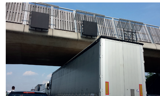
Abbildung 5.6 In den Niederlanden wurden Mauern entworfen, die das Abstrahlen des Lichts von einer Autobahn auf eine Grünbrücke mit einer Flugroute vermeiden sollen (© H. LIMPENS).
