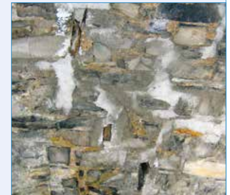
Abbildung 22. Die Unterseite der Lisconny Brücke, Irland. Im Bild die drei Teile der tiefen Spalte, die für die Wochenstubenkolonie von Myotis daubentonii offen gelassen wurde. Die Kolonie befindet sich in dem unteren Abschnitt. Man beachte, wie sorgfältig das Mauerwerk ausgefugt und nicht überdeckt wurde. © C. Shiel
