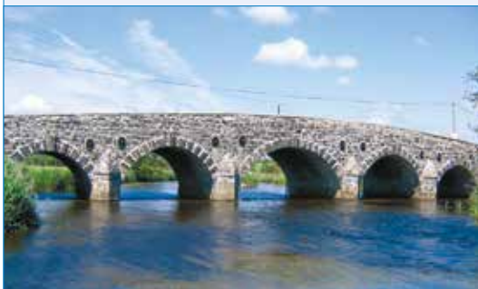
Abbildung 21. Die Lisconny-Brücke, Irland, nach der Restaurierung. © C. Shiel
