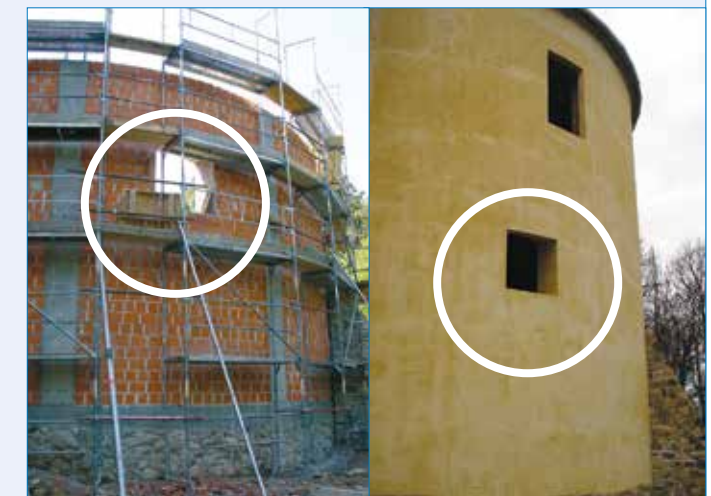
Abbildung 16. Der Nordwest-Turm des Schlosses Grad na Goričkem, Slowenien, während und am Ende des Wiederaufbaus im Jahr 2006 (die Kreise markieren die neuen Einflugöffnungen für Fledermäuse).
