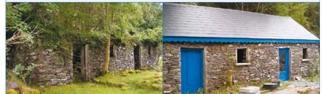
Abbildung 18. Nebengebäude in Glaninchiquin, Irland, vor und nach der Renovierung für Rhinolophus hipposideros .
