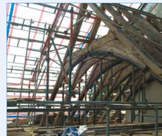
Abbildung 15. Die St. Cadoc's-Kirche, Wales, Großbritannien, wird umfassend renoviert. © C. Roberts
