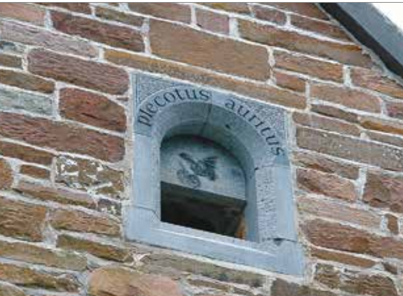
Abbildung 17. Spezielle Einflugöffnung in ein Fledermausquartier, Irland (die auch von Kleinen Hufeisennasen genutzt wird!).
