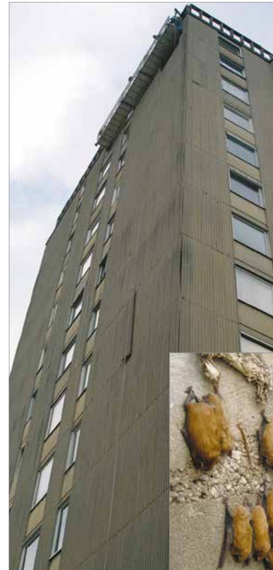
Abbildung 12. Hochhaus in Slowenien, in dem ein Quartier von Nyctalus noctula unter der äußeren Verschalung erst nach dem Beginn der Renovierungsarbeiten bekannt wurde. © P. Presetnik
